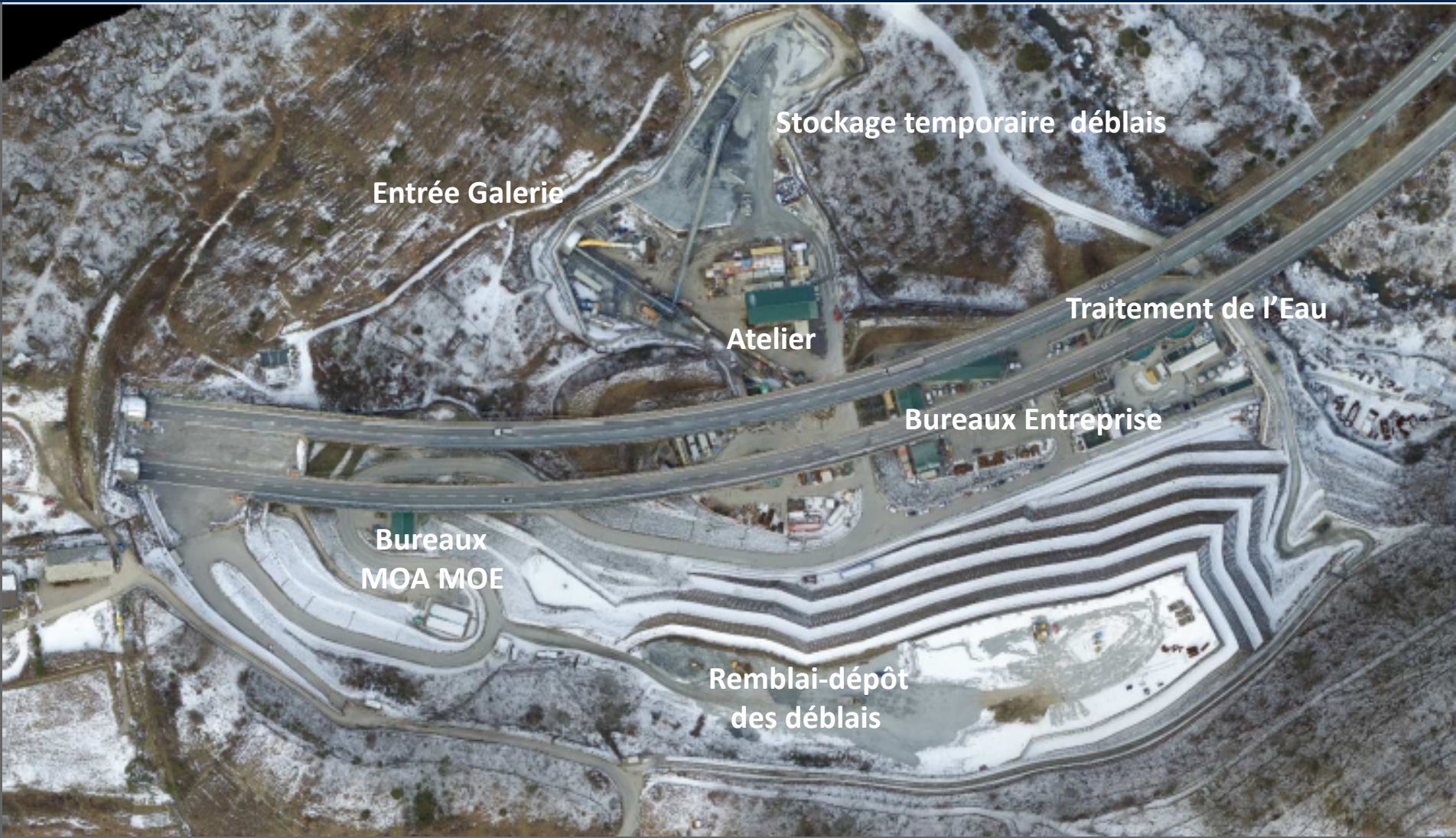
Le chantier de la Maddalena
